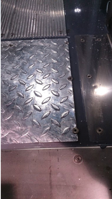
Kuva 14. Kova kaksikomponenttiliimasauma lattiassa.
