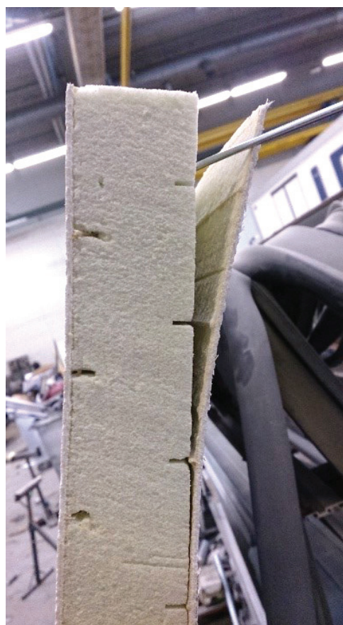
Kuvio 2. Seinäelementin rakenne lasikuitupinnalla ilman vaneria.
