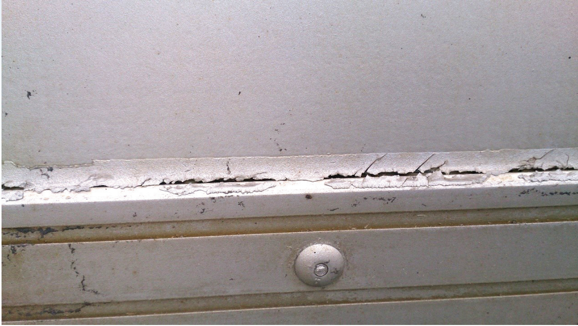
Kuva 12. Vaihtokunnossa oleva saumaus.
